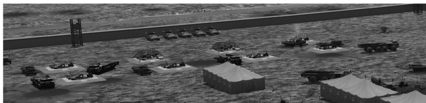
Foto panorámica del estado final de la base.
