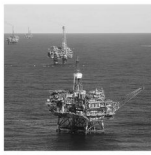
Las plataformas petroleras de la costa de Zimbwana son obsoletas e inseguras de operar. El acuerdo prevé modernizarlas sin afectar sus actividades de otras naciones.
